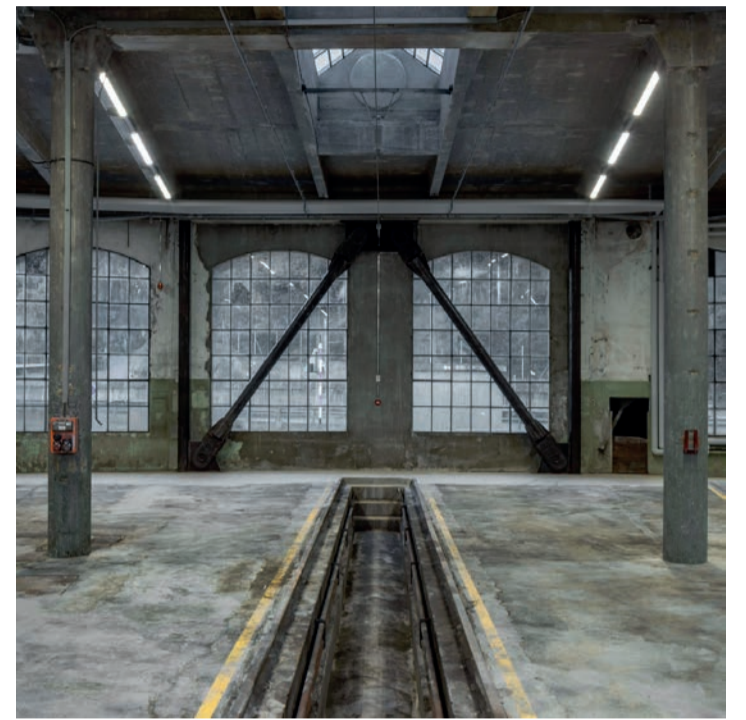
Die A-förmige Stahlkonstruktion sorgt für mehr Stabilität.
