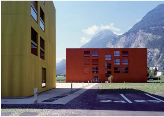
Klare Gliederung der Fassaden in Wandflächen und Fenstergruppen / Subdivision claire des façades en parois aveugles et en groupes de fenêtres
