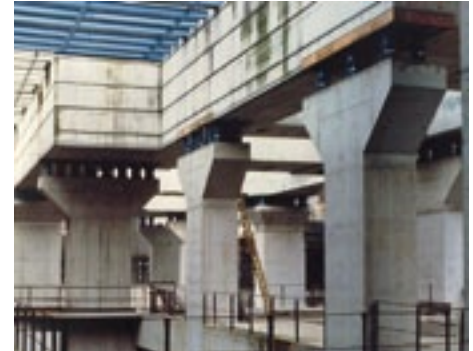
01 Federgelagertes Turbo-Generator-Maschinenfundament in Belgien, 1000 MW, Rohbau (Foto: Peter Trombik)
