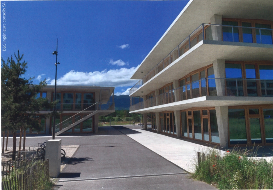
Die Ortbetonkränze der Schulgebäude in Meyrin tragen die horizontalen Kräfte ab.
