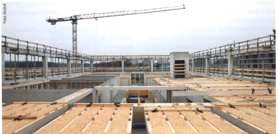
Im Inneren der Exoskelette aus Beton befindet sich Holzbauten.
