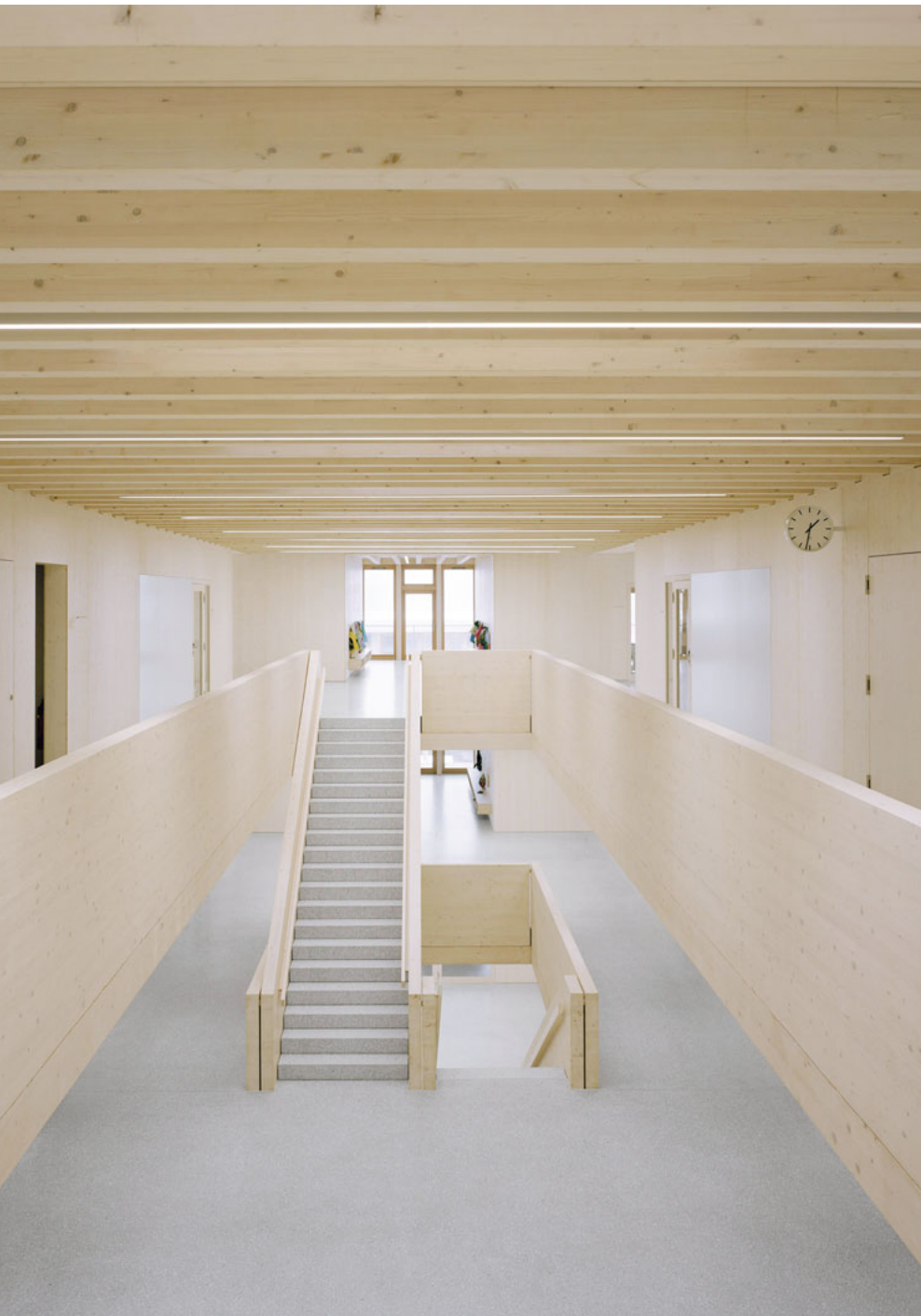
Die neue Schulanlage Les Vergers, Meyrin, präsentiert sich in Hybridbauweise mit Holz und Stahlbeton.
