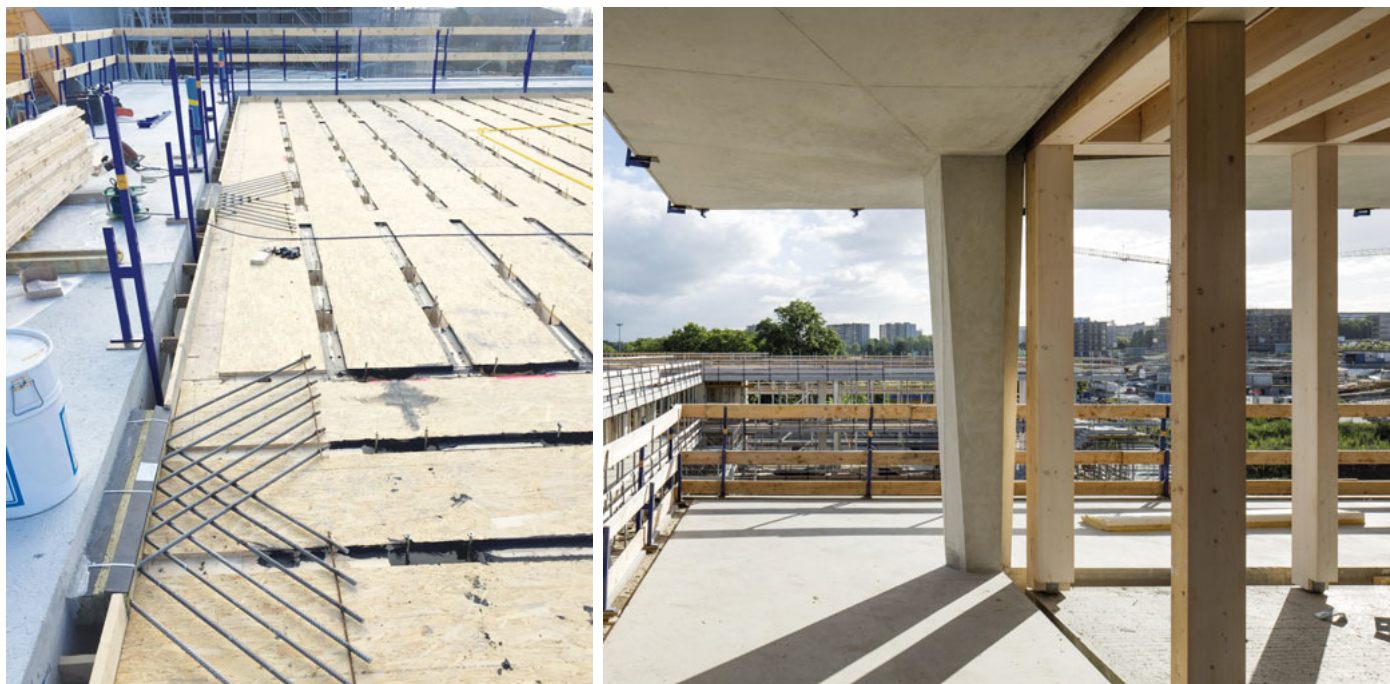
Schulanlage Les Vergers in Meyrin GE im Bau. Mit symmetrischem Grundriss, stetigem Aufriss, klarer Lastabtragung und einwandfreiem Konzept sind die konstruktiven Details gut durchdacht.
