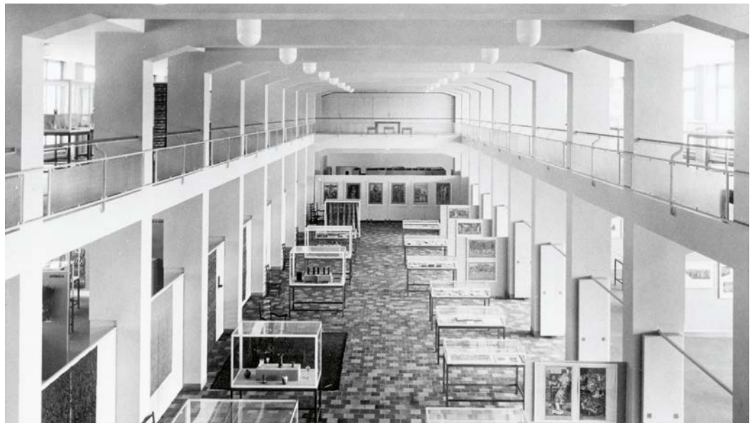
Der ursprüngliche Zustand der Museums-halle, Blick von der Galerie, 1933.
