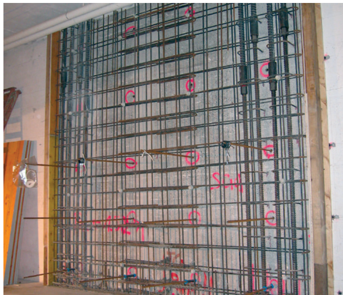
Neue, über die ganze Gebäudehöhe laufende Stahlbetonwände zur Abtragung der Erdbebenkräfte. Das Bild zeigt die fertig montierte Bewehrung. Die Anordnung ist im Grundriss grün eingezeichnet.
