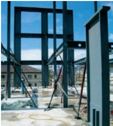
Dreistöckige Rahmen – eine geschickte, aber etwas aufwendige Lösung.
