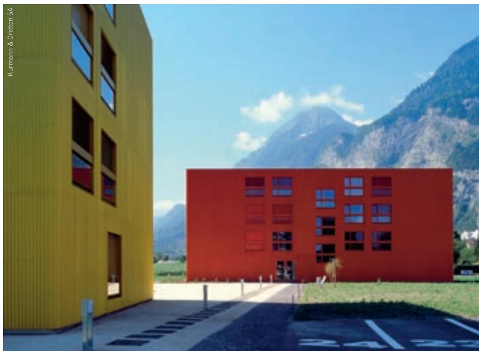
Klare Gliederung der Fassaden in Wandflächen und Fenstergruppen.
