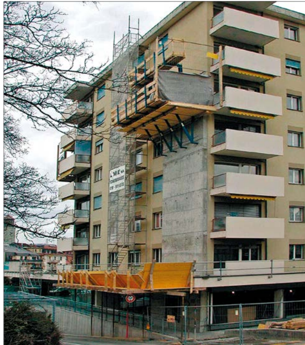
Wohngebäude in Freiburg mit vier aussen an den Fassaden hochgezogenen schlanken Stahlbetonwänden.
