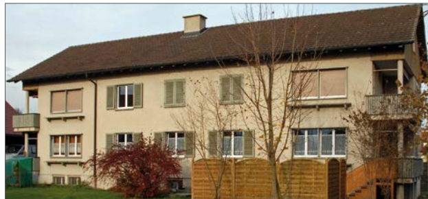
Wohnhaus von 1960 in Kriessern SG: Die Erdbebensicherheit wurde im Rahmen der Planung von Erhaltungsmaßnahmen durch einen spezialisierten Erdbebeningenieur überprüft und als genügend bewertet.
